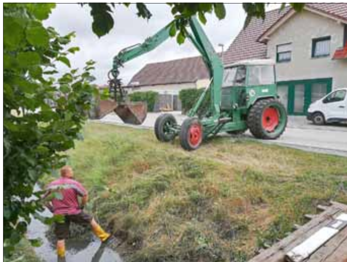
Arbeiten am Seenachbach
